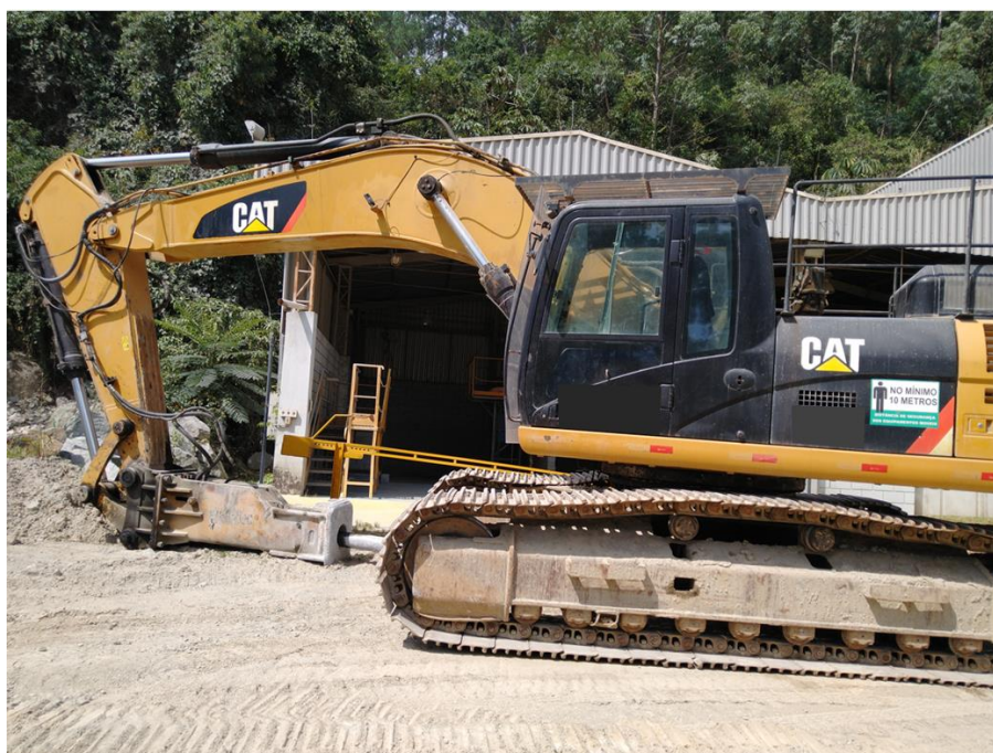
Figura 15 – Vista de retroescavadeira com cabine fechada
