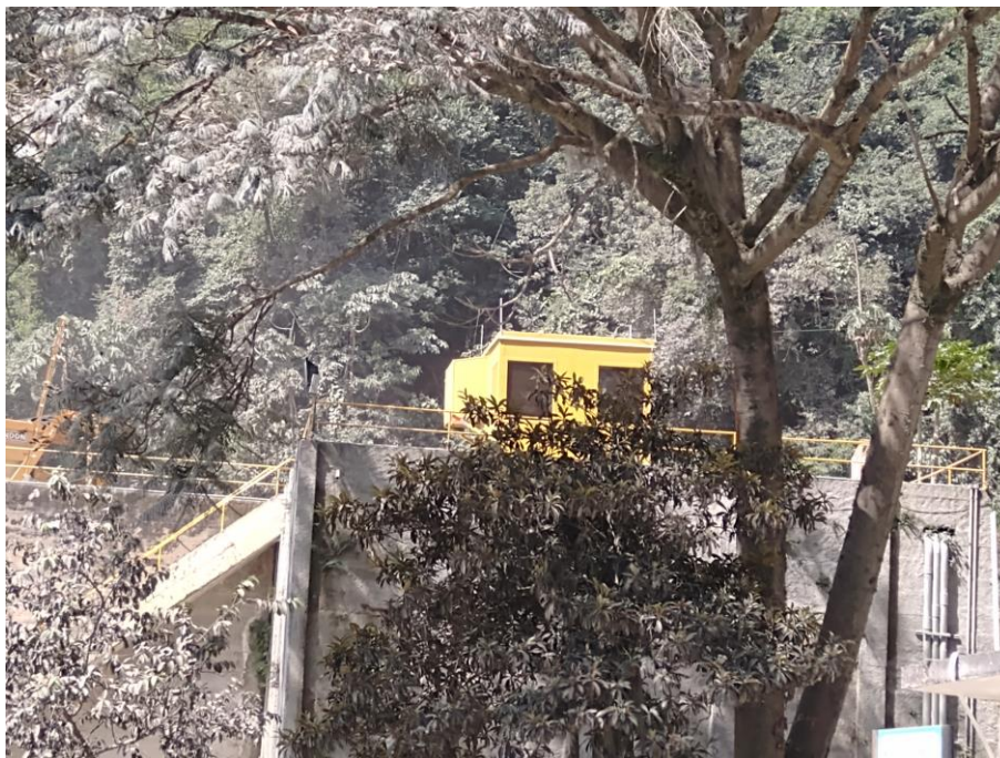
Figura 18 – Vista da cabine fechada da central de comando do britador
