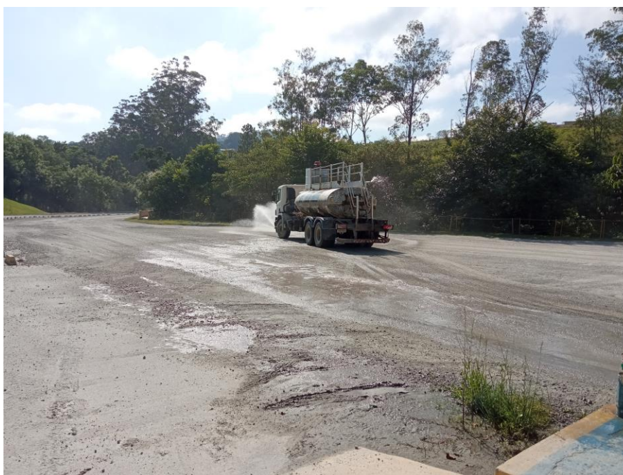
Figura 8 – Caminhão pipa fazendo a umidificação das vias
